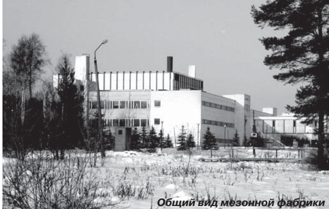
Общий вид мезонной фабрики
