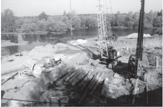
Строительство в прибрежной зоне реки Десны 17-этажного жилого дома "Е21-4"
