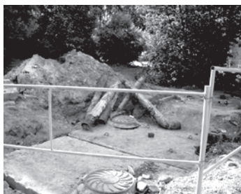
Ремонт теплотрассы на Сиреневом бульваре
